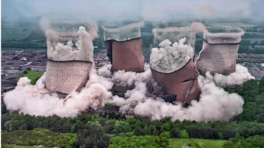
Figura 3.1 – Corrente de gravidade formada pela nuvem de detritos gerada pela implosão de torres de arrefecimento. Fonte: [freepressjournal.in](http://freepressjournal.in) (2021).
