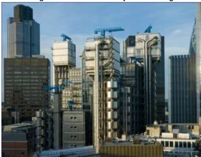
Figura 30 - Edifício Lloyd's Building
