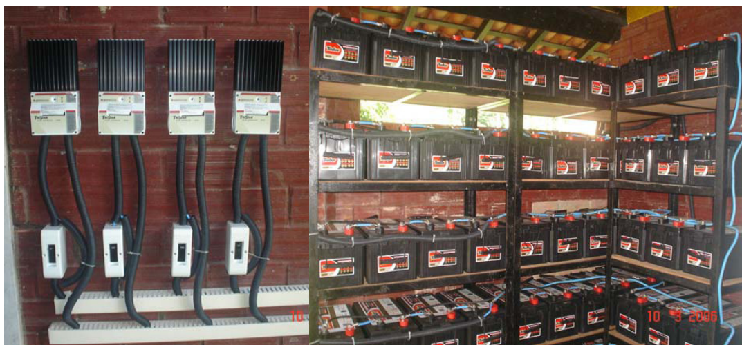
Figura 2.59. (a) controladores de carga e (b) banco de baterias utilizado no sistema fotovoltaico isolado na estação científica Ferreira Penna, PA [45].
