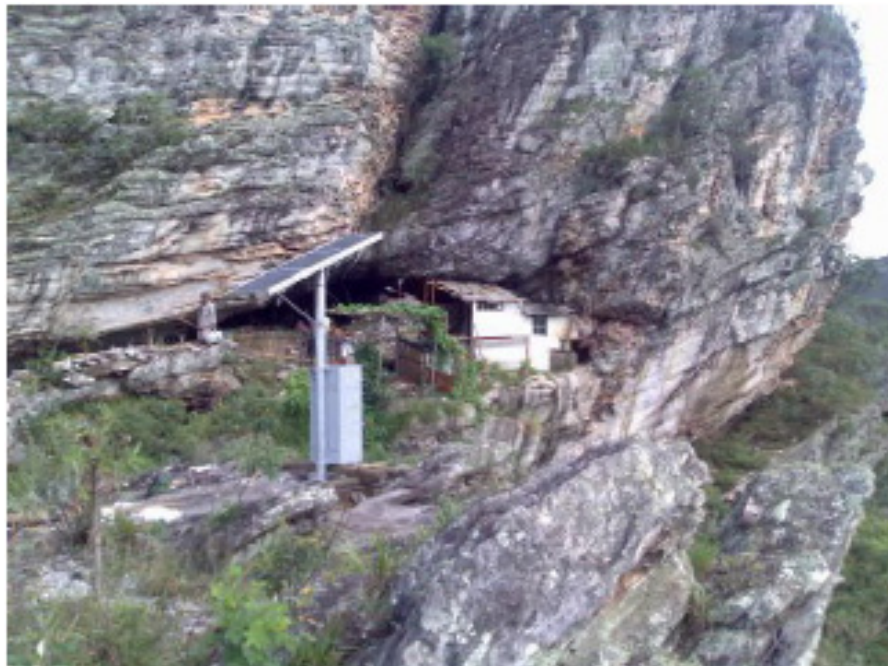
Figura 2.51. Residência atendida por SIGFI, da CEMIG, utilizando módulos fotovoltaicos [42].
