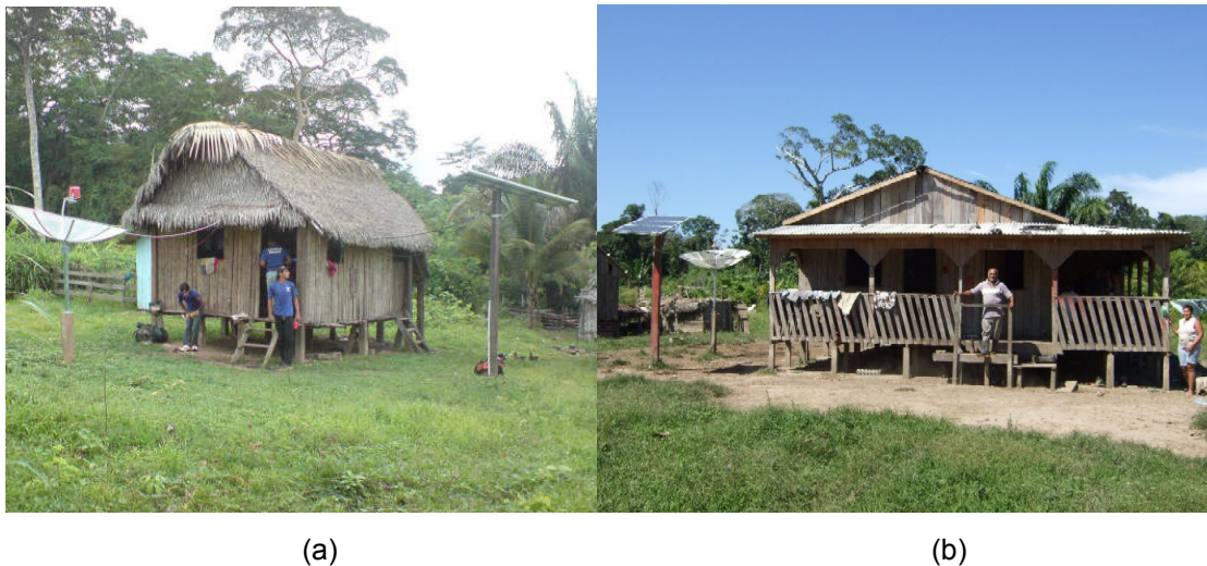
Figura 2.60. Seringais de (a) Albrácea e (b) Dois Irmãos atendidos por sistemas fotovoltaicos isolados SIGFI [46].
