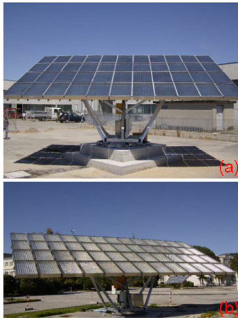
Figura 2.15. Arranjos fotovoltaicos constituídos por módulos fotovoltaicos concentradores Rondine nas cidades de (a) Ferrara e (b) Catânia [20].
