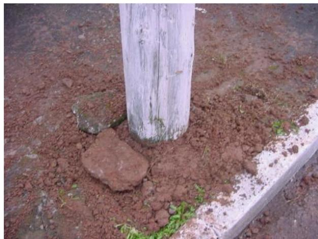
Figura 4.21 Fechamento da cava de inspeção e retratamento.
