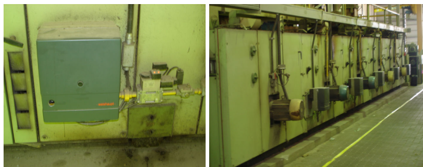
Figura 3.24 - (a) Queimador de gás; (b) Câmaras de secagem.
