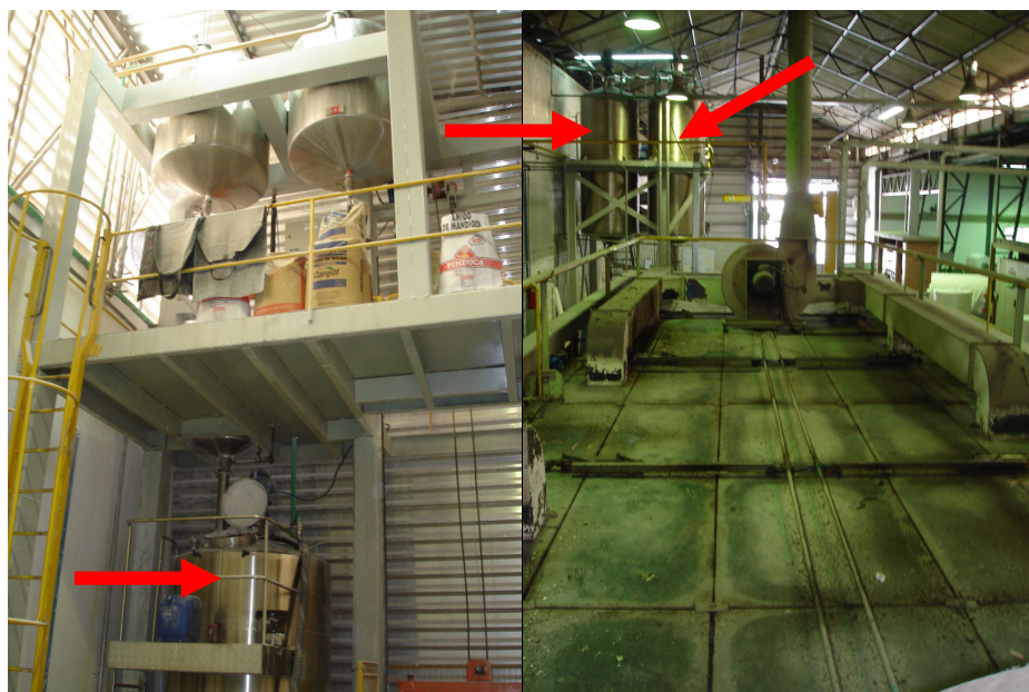
Figura 4.3 - (a) Tanque bateadeira; (b) Tanques de Mistura I e II da Rama.
