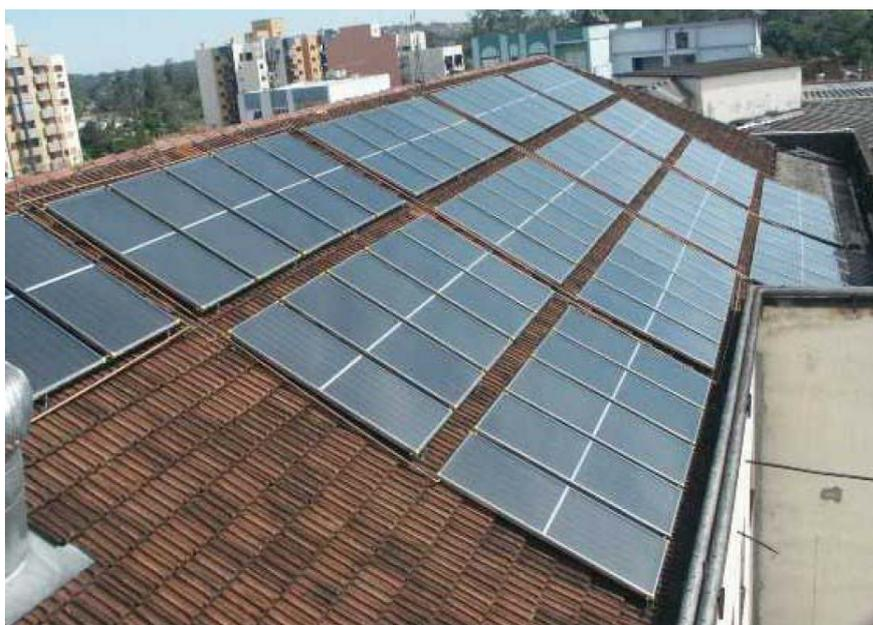
**Figura 3.24. Aspecto dos coletores solares do novo sistema de aquecimento de água em uma amostra utilizada nas análises desta dissertação.**
