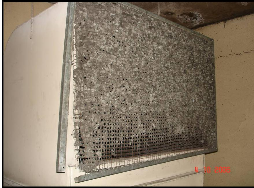
**Figura 3.12. Aspecto da tela de proteção obstruída com sujeira.**
