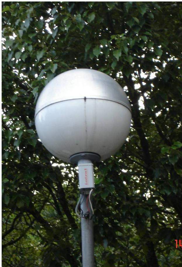
**Figura 3.8. Aspecto da iluminação externa com lâmpadas de vapor de mercúrio.**
