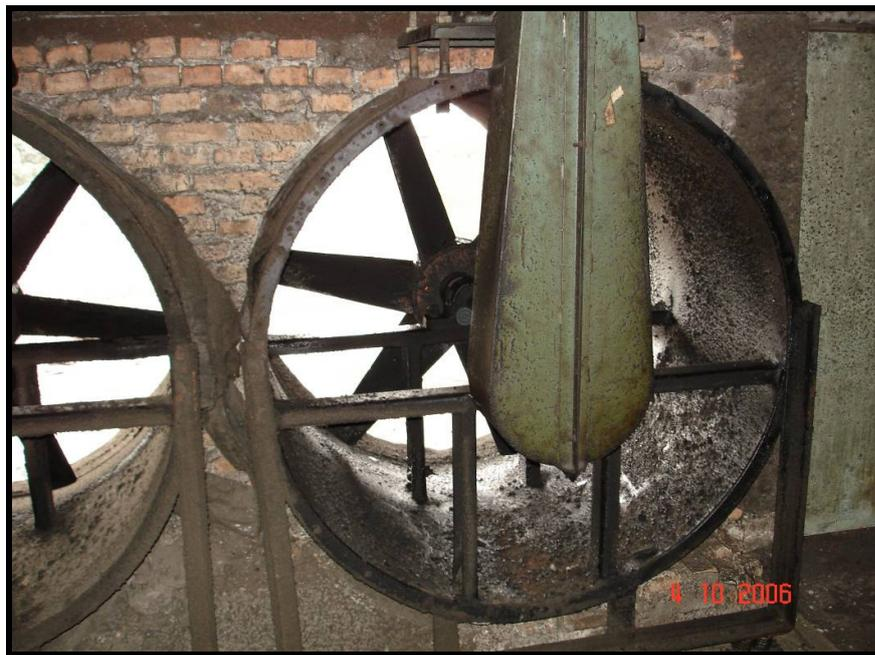
**Figura 3.13. Aspecto do exaustor sem manutenção.**
