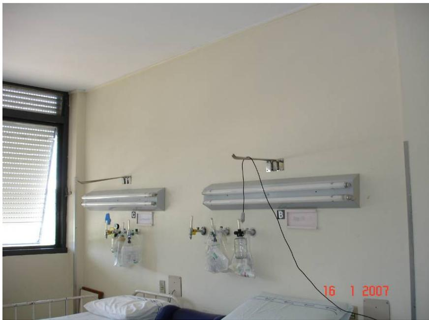
**Figura 3.6. Aspecto da má disposição das luminárias em alguns leitos de um Hospital.**
