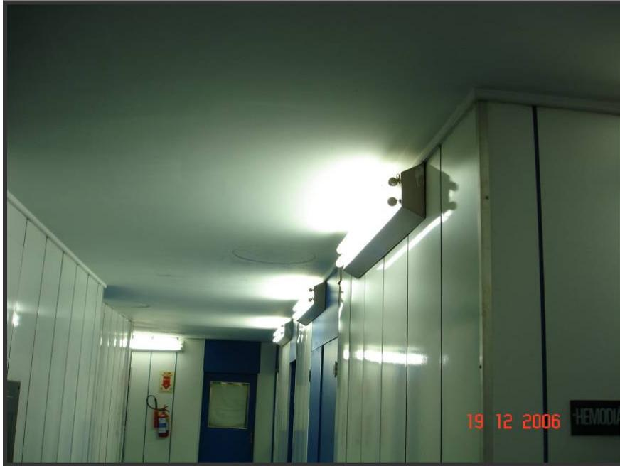
**Figura 3.5. Aspecto da má disposição das luminárias no corredor de um Hospital.**
