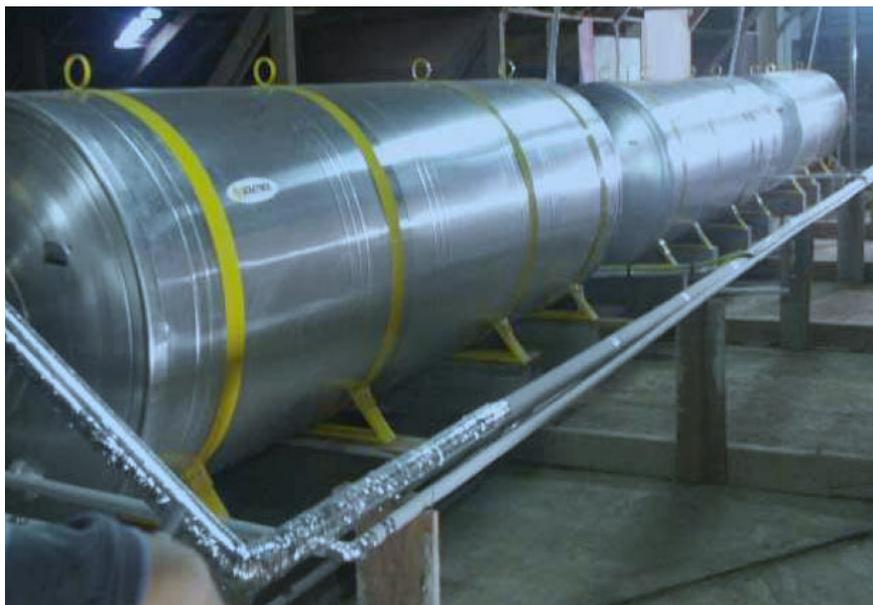
**Figura 3.23. Aspecto dos boilers instalados para o novo sistema de aquecimento de água em um hospital da amostra analisada nesta dissertação.**
