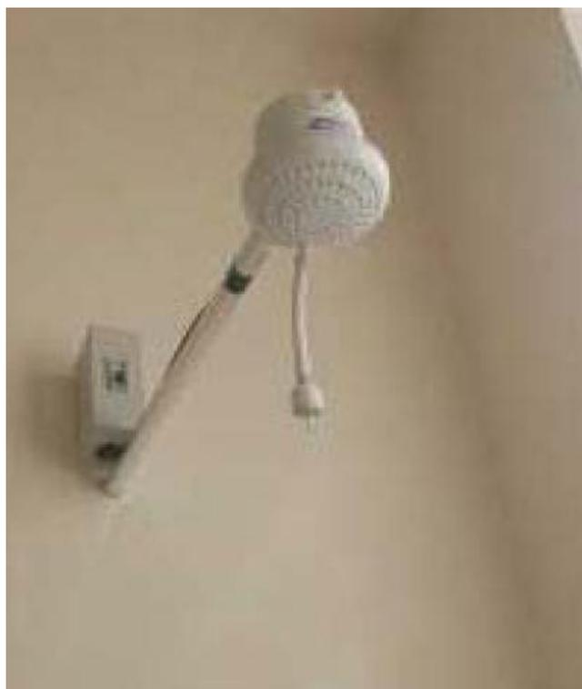
**Figura 3.21. Aspecto de um chuveiro elétrico pertencente ao antigo sistema de aquecimento de água de um hospital analisado nesta dissertação.**
