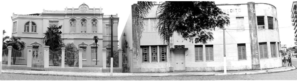
Fig. 88 – Prédio do Instituto São Benedito e do Episcopado. Rua Senador Mendonça. Fonte: Foto da Autora, 2003
