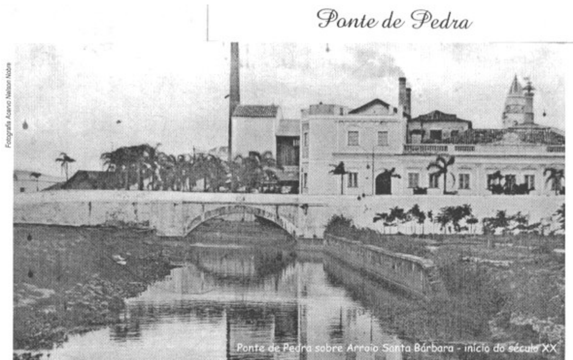
Fig. 122 – Ponte de Pedra, sobre o Arroio Santa Bárbara. Fonte: Acervo Pelotas Memória, década de 20
