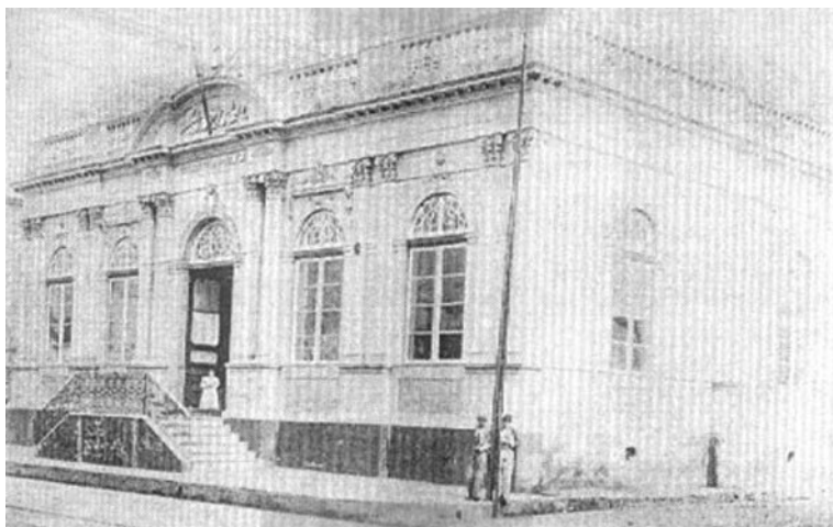
Fig. 34 – Biblioteca Pública, antes da reforma.
