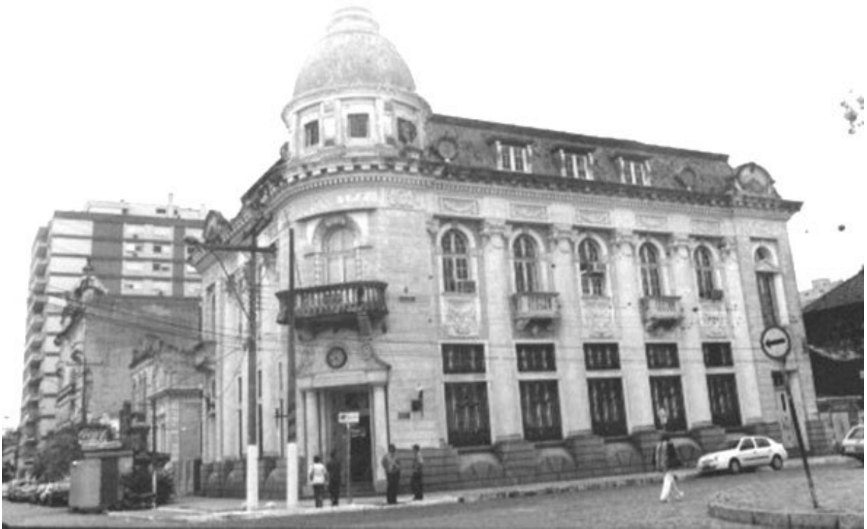
Fig. 47 – Banco do Brasil, atual Órgão da Prefeitura. Fonte: Foto de Neco Tavares, 2003
