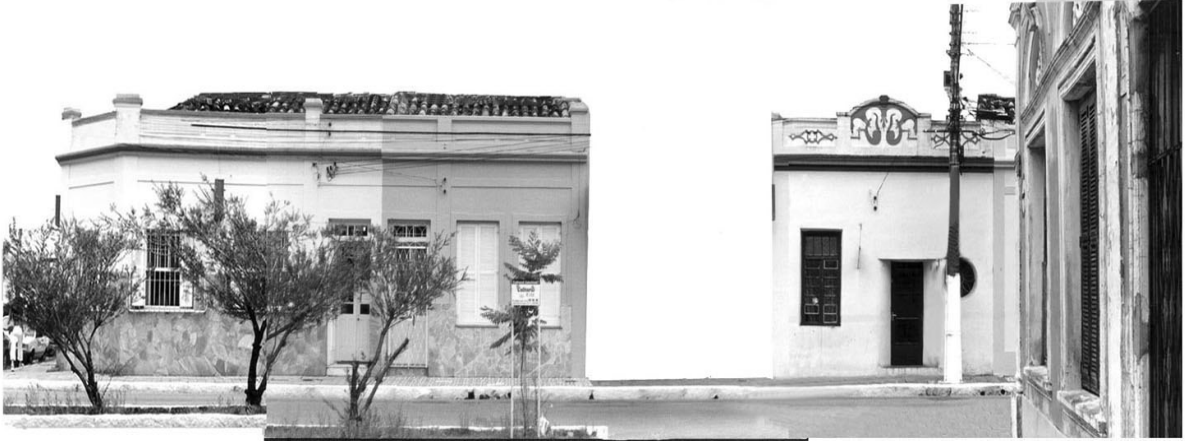
Fig. 91– Prédios residenciais em fita, Rua Félix da Cunha. Fonte: Foto da Autora, 2003
