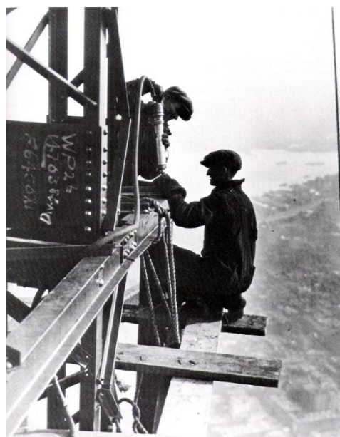
Figura - 29 Operários do edifício Empire State. Nova Iorque, 1931 [Lewis W. Hine].
