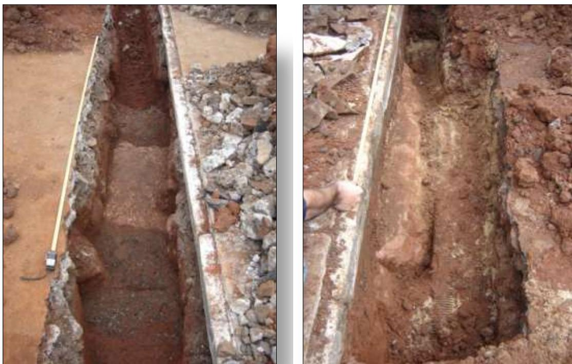
**Foto 12 e 13. Alicerces jesuíticos evidenciados durante vistoria arqueológica das obras de infraestrutura para telefonia em frente à Igreja Matriz de São Borja. À esquerda, alicerce em pedra grés e itacuru da parede Leste e, à direita, alicerce em pedra grés da parede Oeste da antiga igreja da redução de São Francisco de Borja.<sup>170</sup>**
