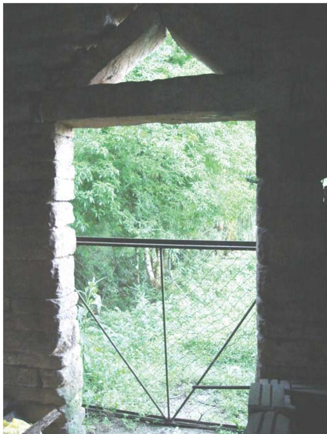
Figura 125: Triângulo de pedra Grés, na parte superior das aberturas
