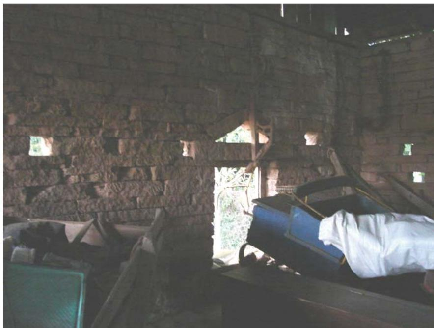
Figura 126: Paredes de blocos irregulares de arenito e argamassa feita de barro
