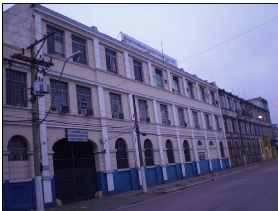
Figura 42 - Foto de agosto de 2010 da edificação que sediou a Cia. Fabril, na Voluntários da Pátria, nas proximidades da João Inácio, em 1922. Fonte: Fotografia da autora.
