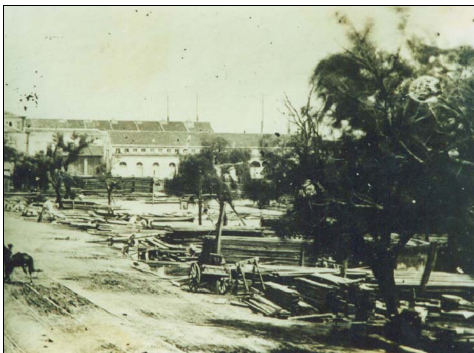
Figura 12 - Rua Voluntários da Pátria, construção do Cais,1911. Fonte: PESAVENTO, 1996,op.cit.,p.47.
