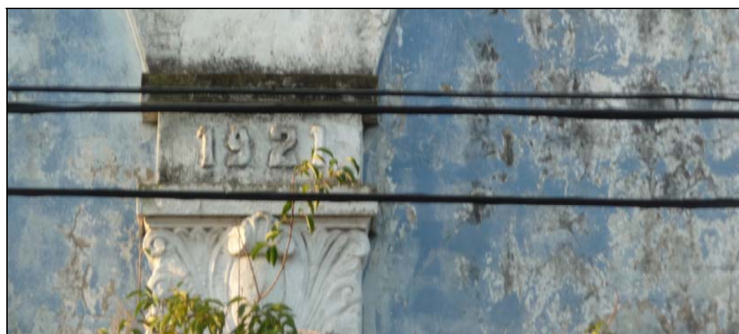
Figura 45 - Imagem do antigo conjunto de edificações da fábrica Wallig, contrastando com a degradação das fachadas atuais (agosto de 2010). Fontes: PORTO ALEGRE :BIOGRAFIA D'UMA CIDADE,1940,op.cit.,p.530; fotografia da autora.
