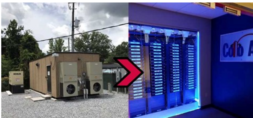
Figura 2.2: Visões externa e interna de um sistema de Mobile Edge Computing
