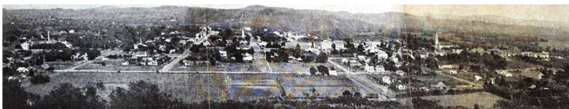
Imagem 66: Fotografia oblíqua do perímetro urbano de São Sebastião do Caí, vista a partir do Morro do Martim, 1928. (MASSON, 1940, p. s/n, entre 36 e 37).
