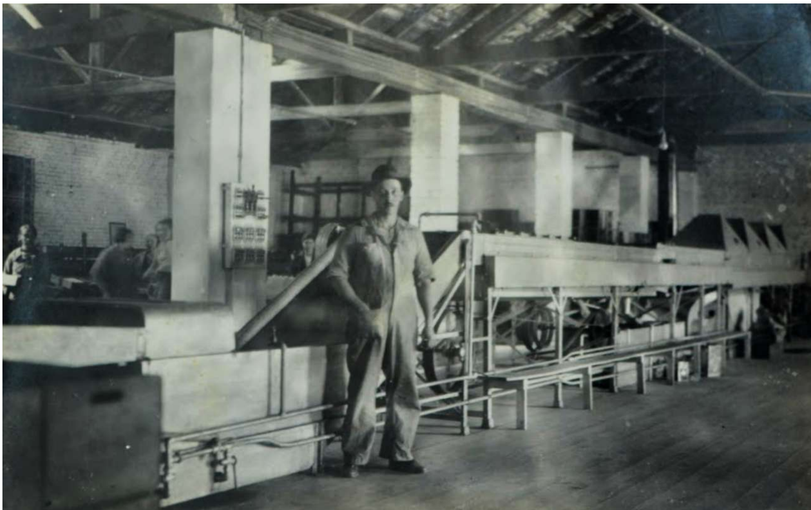
Imagem 71: Fotografia original do acervo do Museu Histórico Vale do Cahy. Publicada por Masson com a legenda: Interior do “ packing house ” de laranjas. À frente vê-se a máquina de limpar frutas; nos fundos, o aparelhamento para seleção. (MASSON, 1940, p. s/n, entre pp. 60 e 61). Década de 1930.
