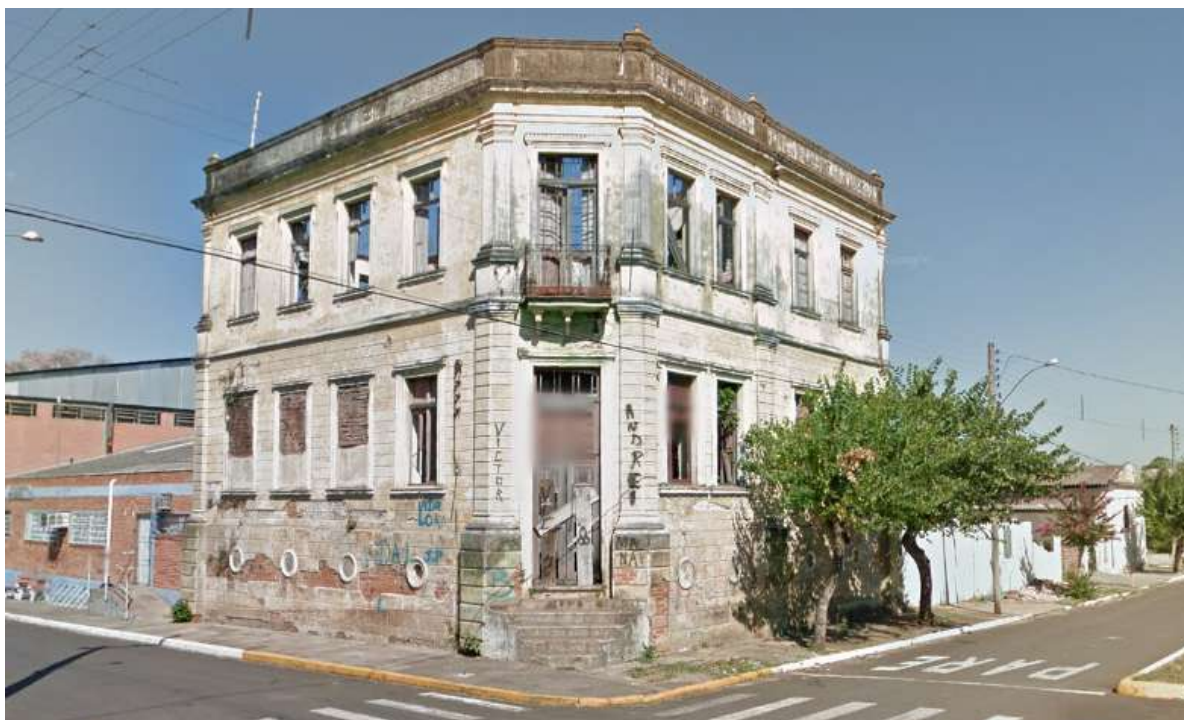
Imagem 67: “Antigo presídio”. Google StreetView, abr. 2012.
