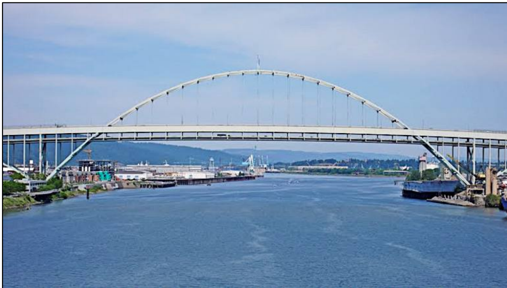
Figura 32: Ponte Fremont em Portland, Oregon, Estados Unidos
