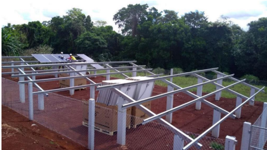
Figura 4.11. Estruturas metálicas e início da instalação dos módulos fotovoltaicos.
