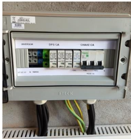
Figura 4.20. Quadro de comando e proteção CC.
