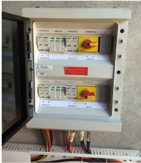
Figura 4.20. Quadro de comando e proteção CC.
