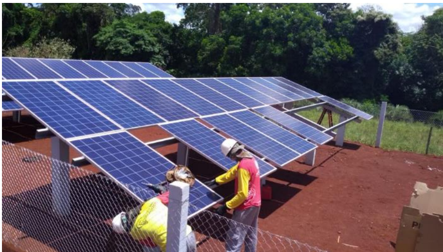
Figura 4.12. Instalação dos módulos fotovoltaicos.
