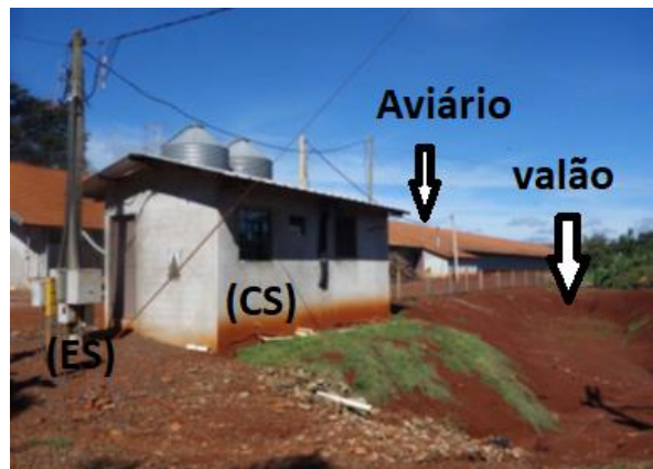
Figura 4.8. Valão presente entre sistema FV e Casa de Passagem (CS).
