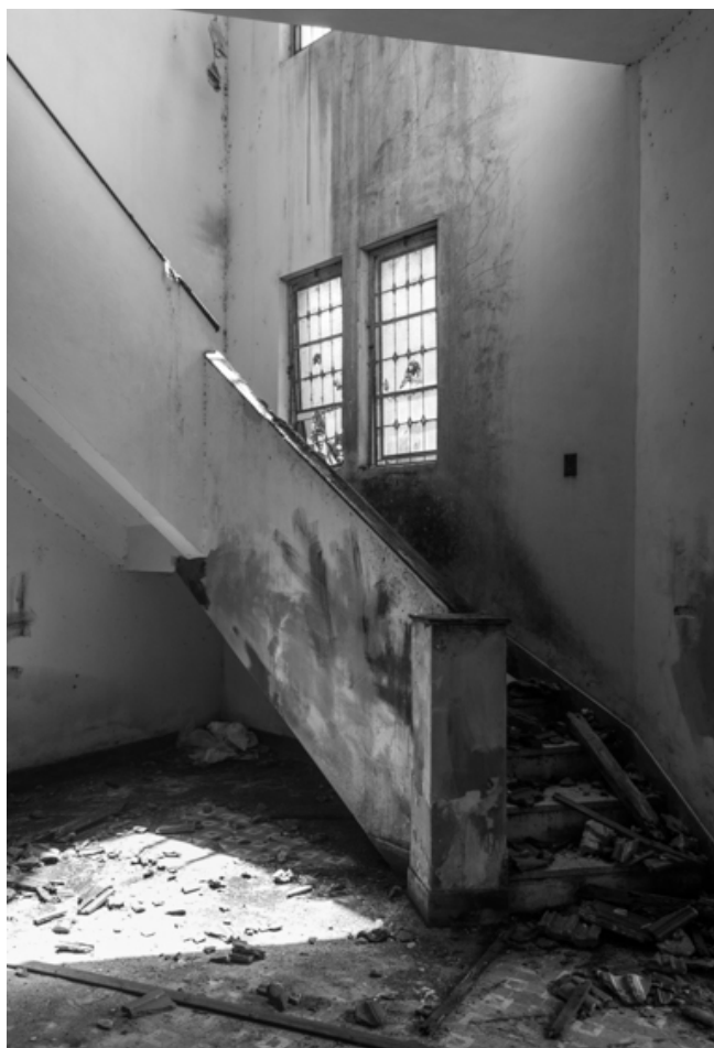
Figura 19. Salão Hospital Colônia Itapuã. Fonte: Arquivo pessoal.
