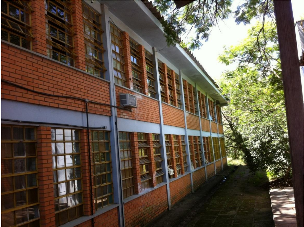
Figura 4 – Lateral do prédio A
