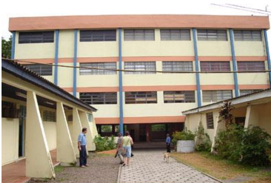
Figura 27 - Instalações provisórias do campus Alegrete
