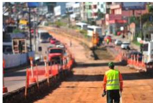
Obras do sistema BRT Fonte: Prefeitura Municipal de Porto Alegre.
