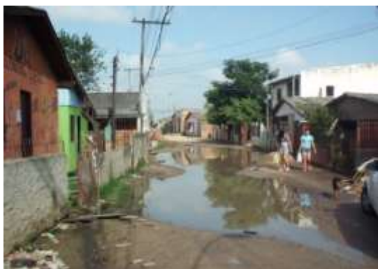
Foto: Flávio Antônio Damiani Fonte: Rede de Esgoto na Vila Nazareth. < http://www.drthiagoduarte.com.br/cosmam/193-rede-de-esgoto-na-vila-nazareth >.
