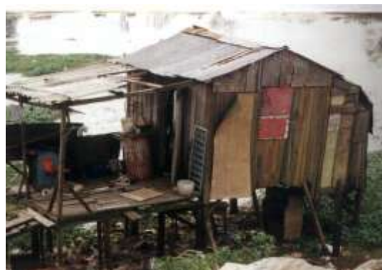
Vila Dique, palafitas construídas às margens do Dique em área de inundação.
