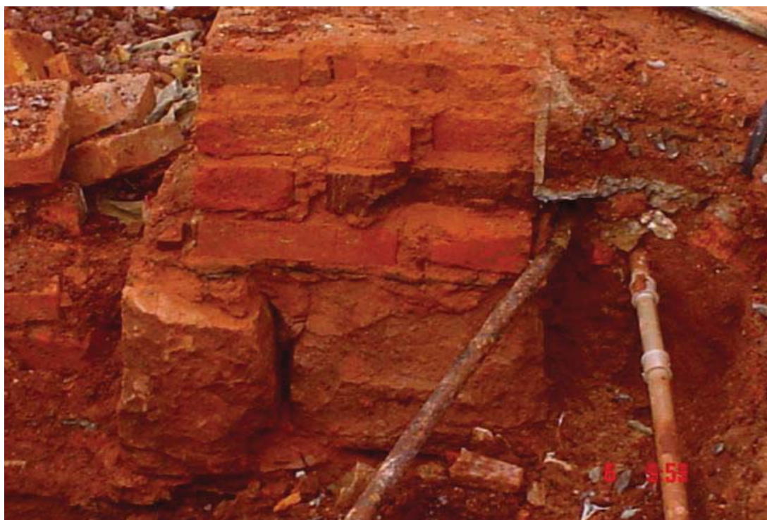
FIGURA 33D - Alicerce de pedra grés, sem cimento, sobreposto de piso, aterro e novo piso. Quarteirão a Oeste da Praça da Matriz (Frente) Fonte: BRESSAN VIEIRA (2009). Fotografado por José Alberto Pinheiro Vieira.
