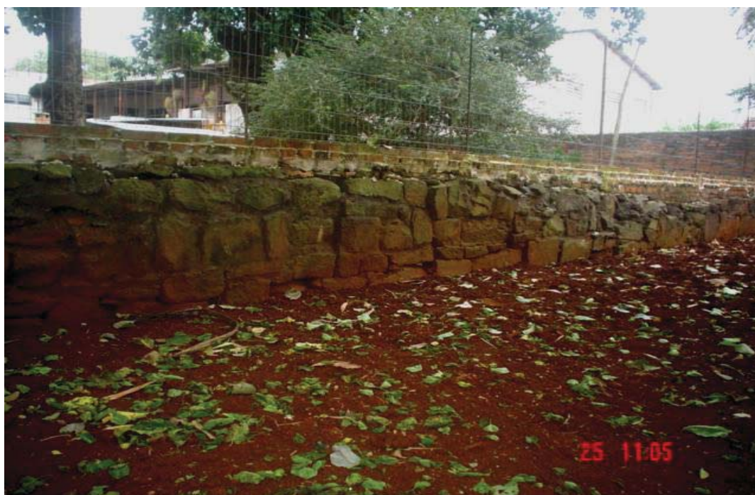
FIGURA 30B - Fundo de residência, no quarteirão a oeste, da Praça da Matriz - local provável de parte da redução
