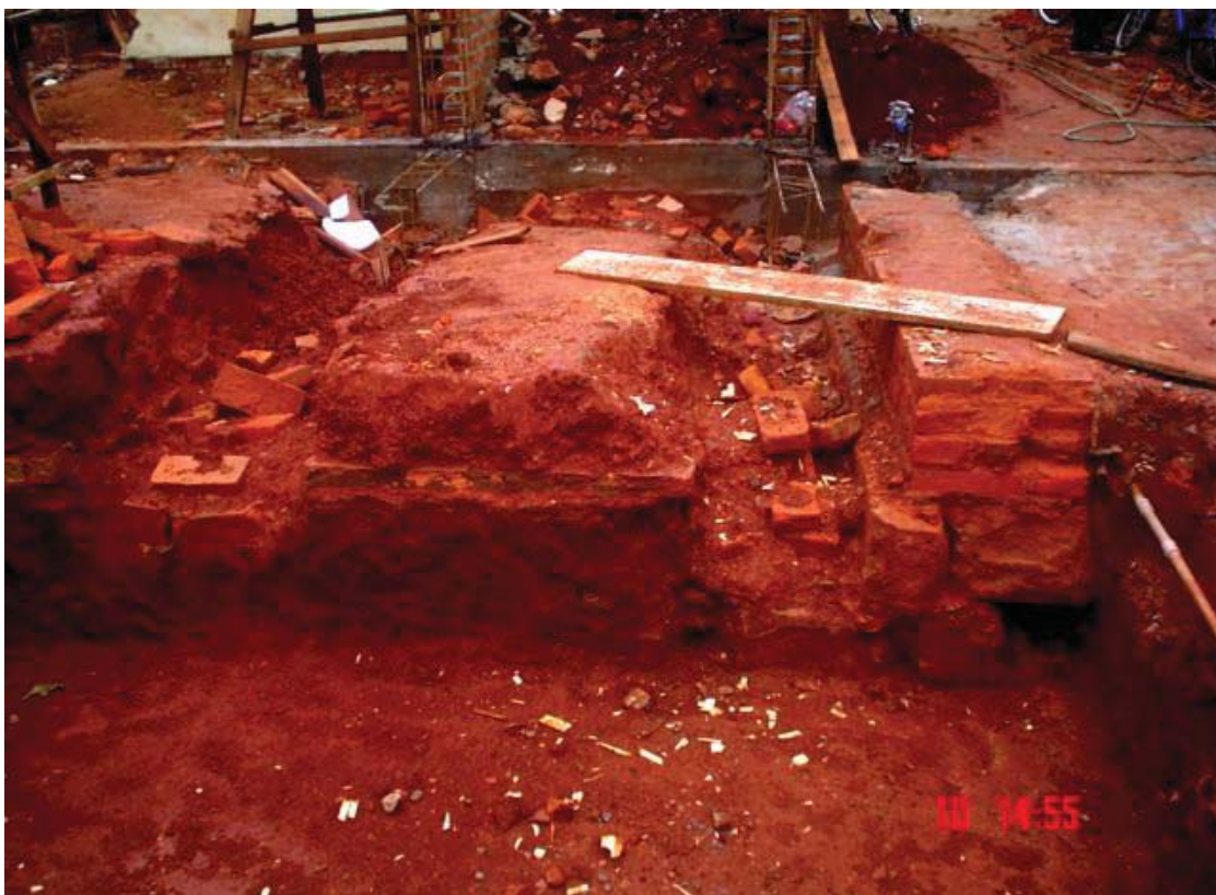
FIGURA 33B - Alicerce de pedra grés, sem cimento. Quarteirão a Oeste da Praça da Matriz (Frente)
