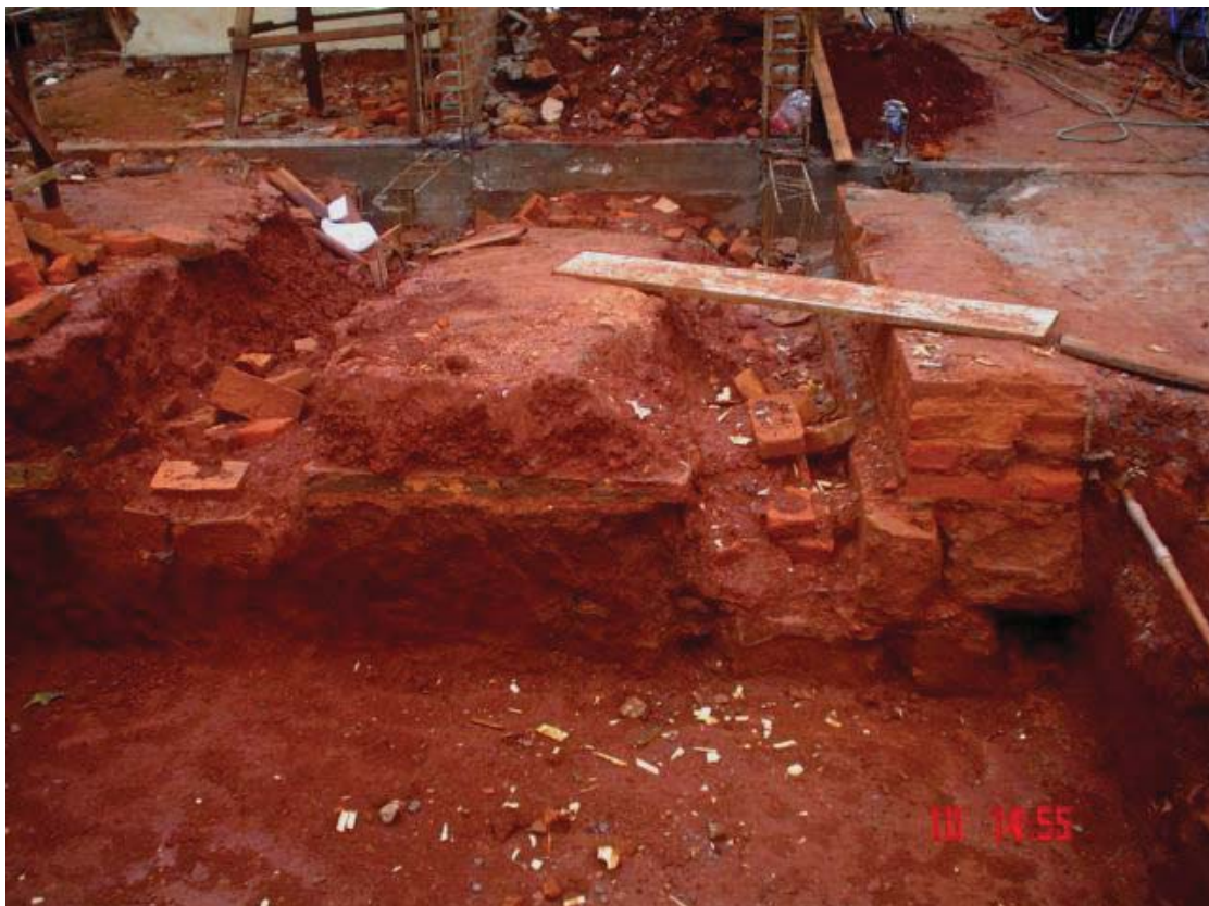
FIGURA 33A - Terraços de Pisos (três camadas) observados em demolição de prédio no quarteirão a Oeste da Praça da Matriz (Frente)
