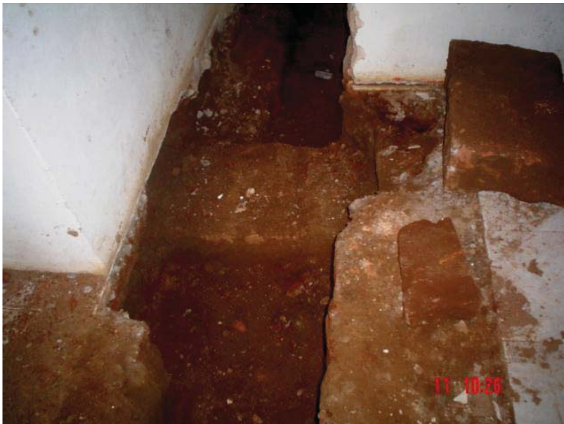
FIGURA 38D - Antiga Pensão Santo Antônio. Ao lado da casa do Sr. Aguiar. Desmanche da construção evidencia o material
