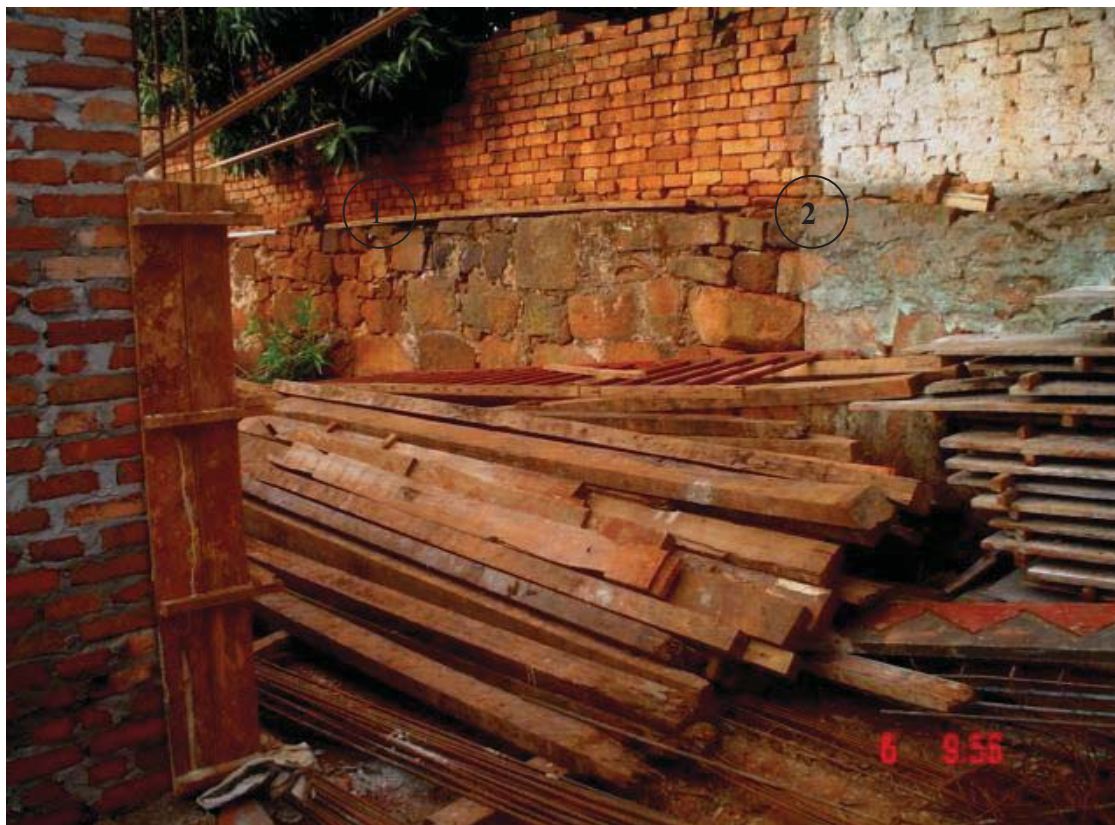
FIGURA 33F - Entulho de demolição: 1- Pedras sobrepostas em junta seca. 2- Pedras unidas por argamassa (construção moderna). Quarteirão a Oeste da Praça da Matriz (Fundos)
