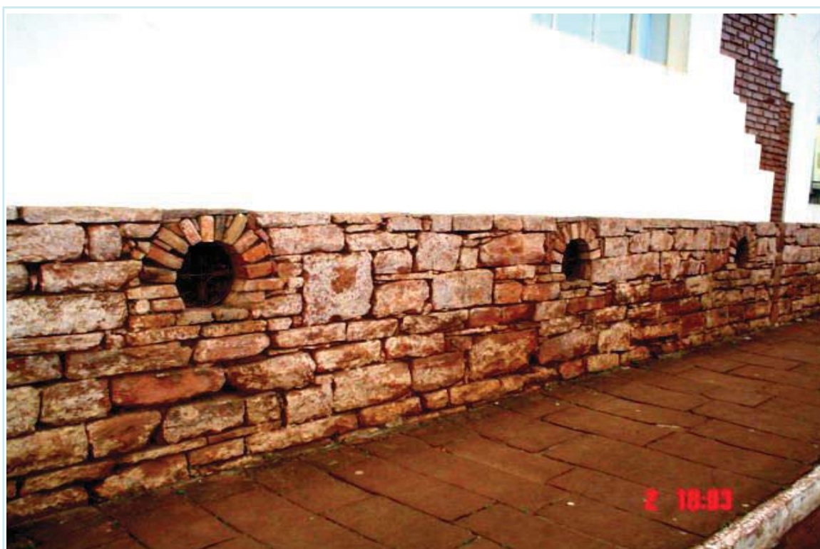
FIGURA 31A - Paredes de prédio original remodelado no final do século XX no quarteirão sul da Praça da Matriz
