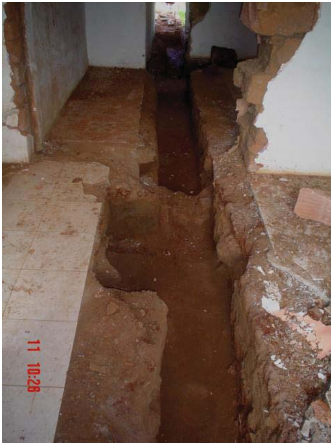
FIGURA 38E - Antiga Pensão Santo Antônio. Ao lado da casa do Sr. Aguiar. Desmanche da construção evidencia o material
