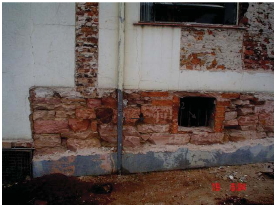
FIGURA 27A - Alicerces de casa à rua Gen. Salvador Pinheiro
