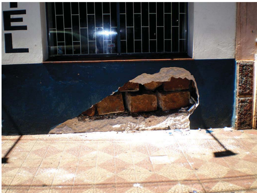
FIGURA 37B - Reforma de prédio na quadra norte da Praça da Matriz identificado como material da Redução
