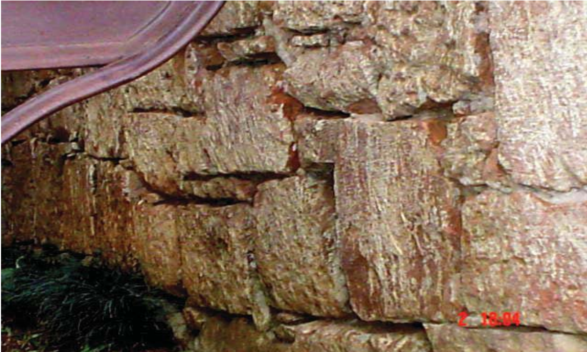
FIGURA 31B - Parede com todas as características de um conjunto original de construção jesuítica Fonte: BRESSAN VIEIRA (2009). Fotografado por José Alberto Pinheiro Vieira.
