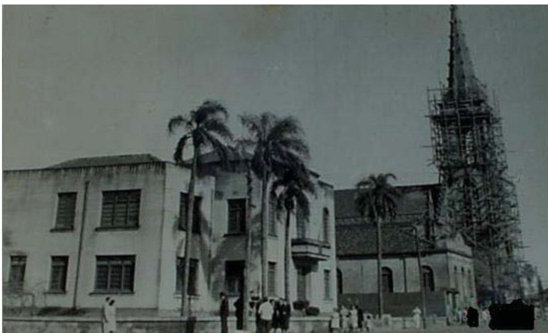
FIGURA 25 - Nova Igreja da Matriz em construção. Em primeiro plano, o prédio já, da nova Prefeitura Municipal, com proposta de construção, em 1945, por Gustavo Langsch Fonte: Acervo Museu Municipal Senador Pinheiro Machado.
