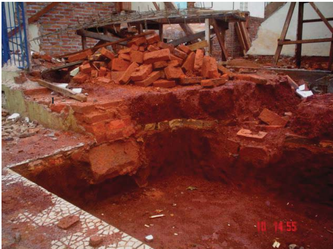
FIGURA 33C - Alicerce de pedra grés, sem cimento. Quarteirão a Oeste da Praça da Matriz (Frente) Fonte: BRESSAN VIEIRA (2009). Fotografado por José Alberto Pinheiro Vieira.
