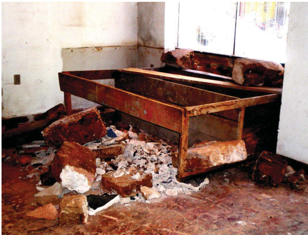
FIGURA 37C - Reforma de prédio (Interior) na quadra norte da Praça da Matriz identificado como provável material da Redução
