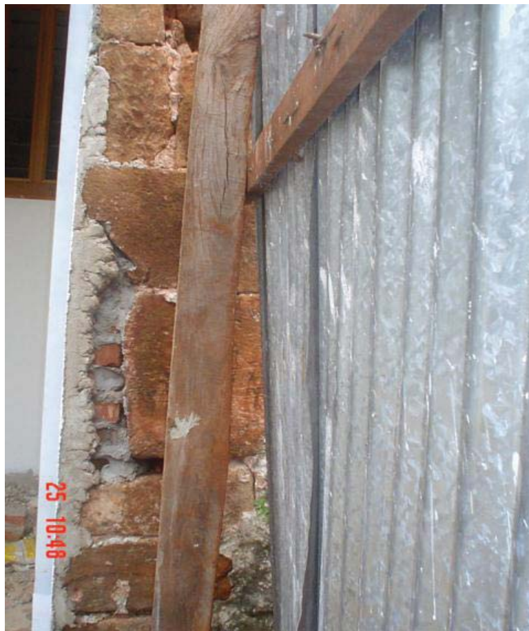
FIGURA 28B - Presença da pedra grés: demolições, muros altos. Quarteirão sul da Praça da Matriz
