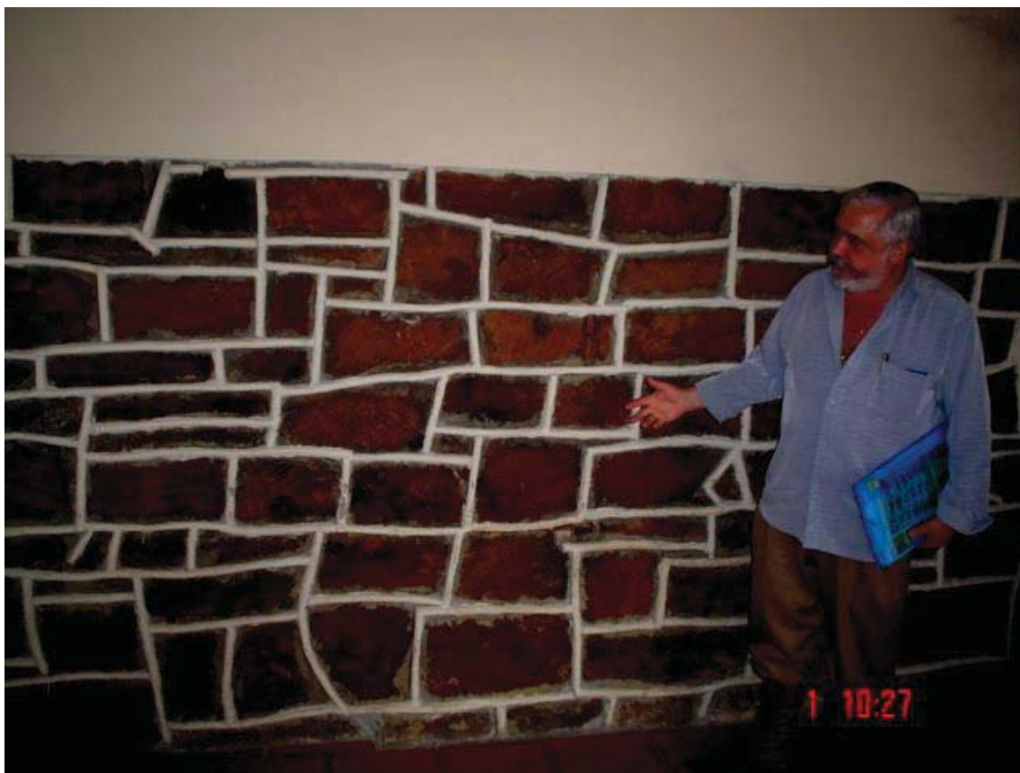
FIGURA 39 - Parede interna de prédio no quarteirão da planta da redução. Quadra sudeste da Praça da Matriz
