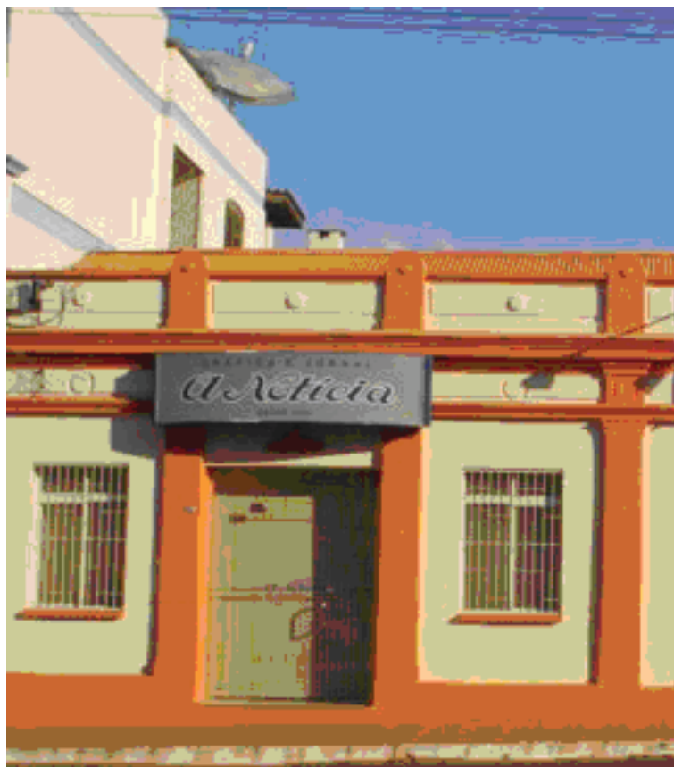
FIGURA 51 - Prédio A Notícia (1926)
