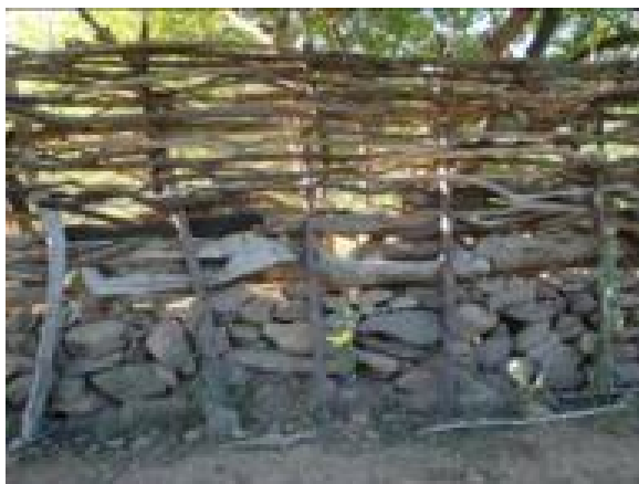
Figura 17 - Cerca de pedra e trançado de varas no município de São João do Tigre-PB.
