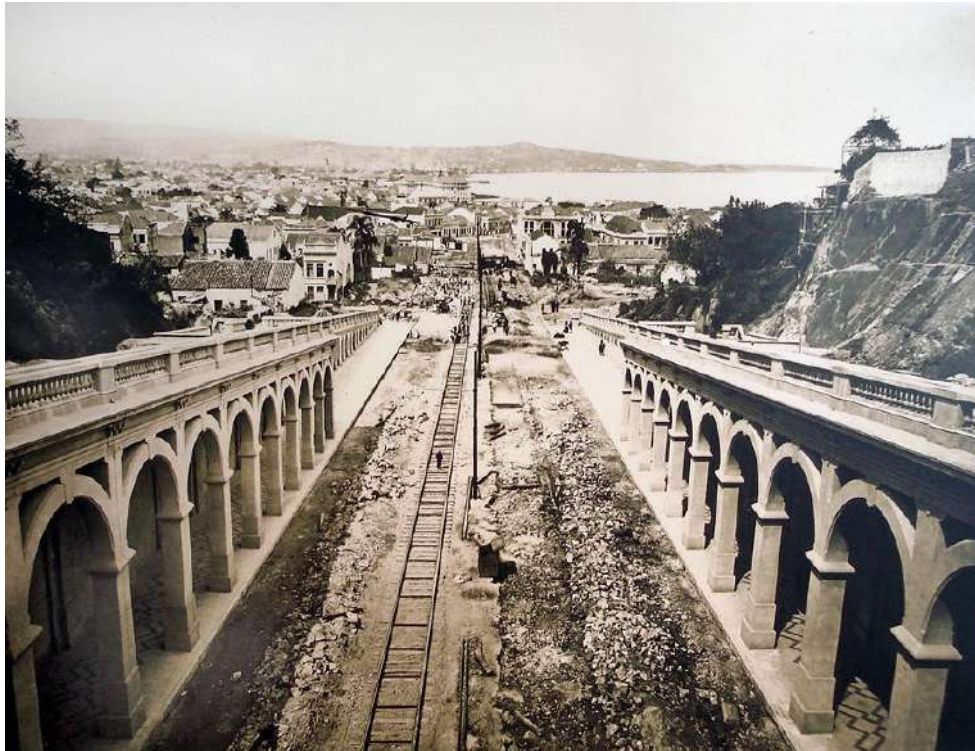
FIGURA 2: Construção do viaduto Otávio Rocha
